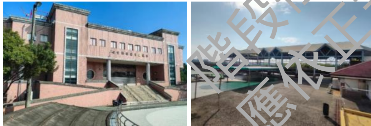
圖 3-2 育樂活動中心及游泳池既有建物現況
